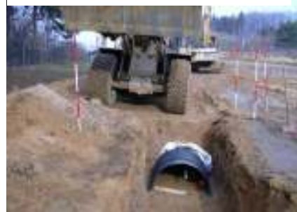
Aanleg infiltratietunnel
