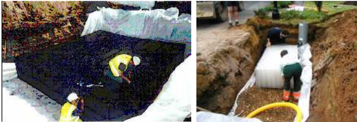
Aanleg van infiltratiebekken met infiltratieblokken
