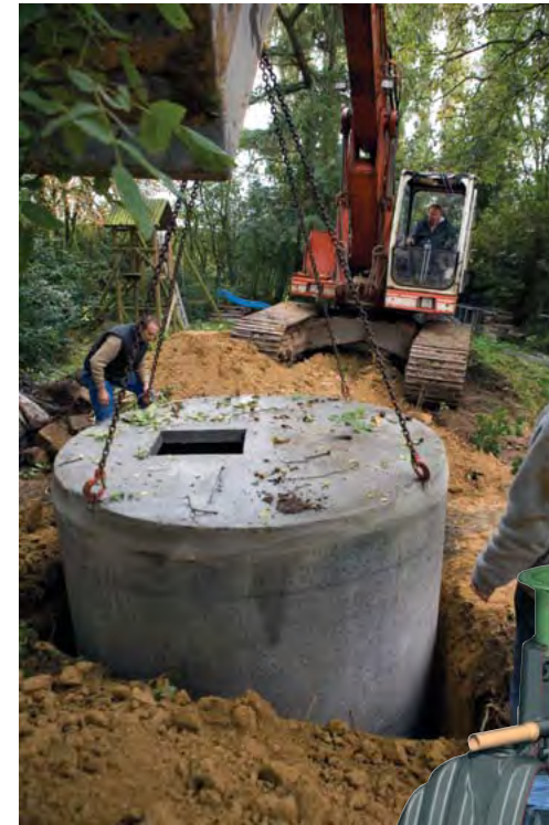
Betonnen en kunststof regenwaterput
