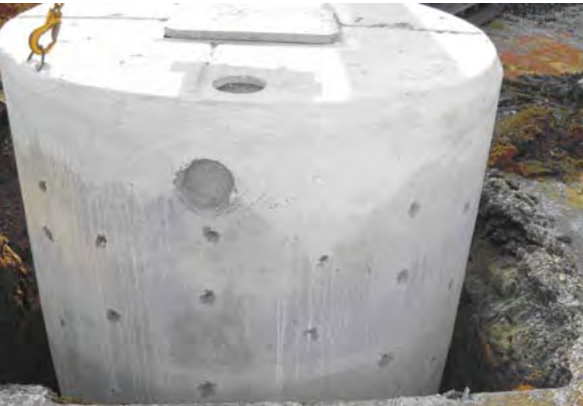
Betonnen infiltratieput
