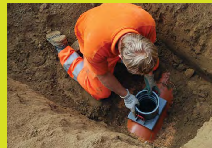
Realisatie rioolaansluiting
